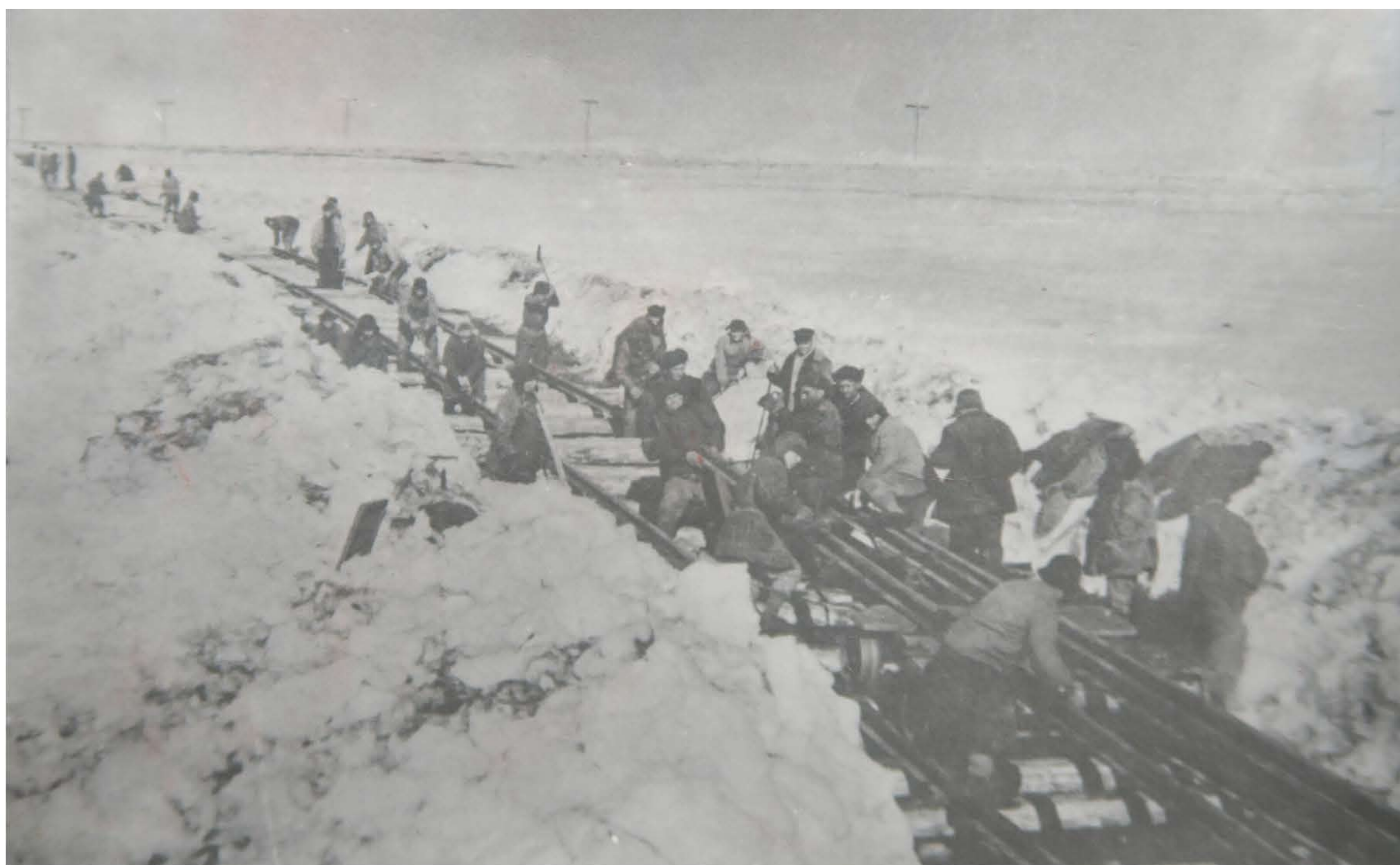
Stavění železnice za mrazivých podmínek.
